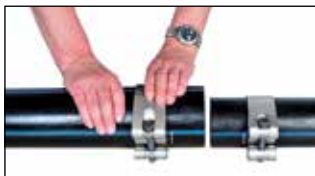
Schellen über die zu verbindenden Rohre schieben.
