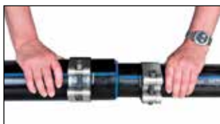
Zweites Rohr bis zum Anschlag auf die Reduktion schieben.
