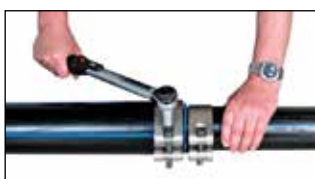
Schrauben mit dem Drehmomentschlüssel auf das angegebene Anzugsmoment anziehen. Wechselseitiges Wiederholen des Anziehprozesses bis alle Schrauben innerhalb einer Viertelumdrehung (90°) das angegebene Drehmoment erreichen.
