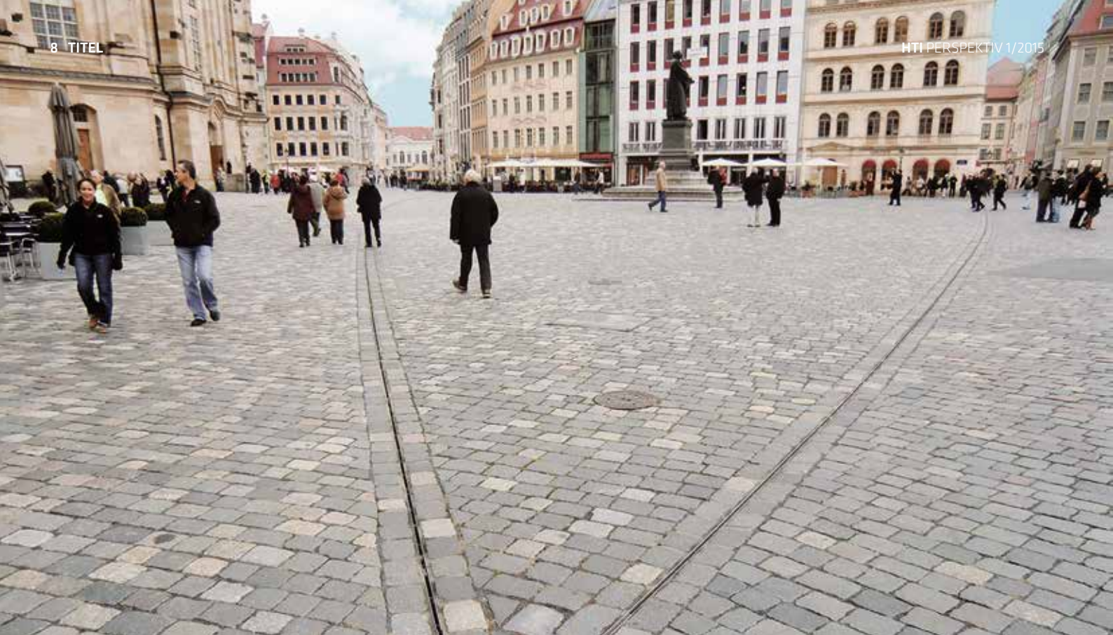
Der Neumarkt in Dresden setzt auf die Entwässerung mittels Schlitzrinnen (Quelle: Hauraton, Rastatt)
