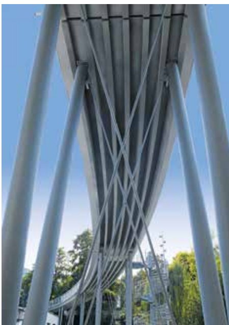
Die Textilbetonbrücke in Albstadt-Lautlingen ist ein technologisches Leuchtturmprojekt. (Quelle: Groz-Beckert)
