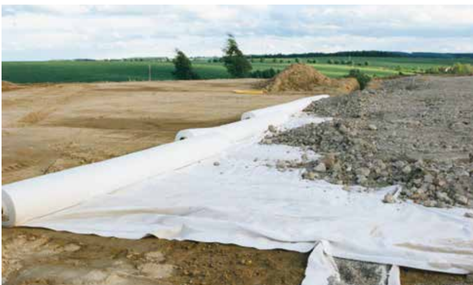
Geotextilvlies ist ohne Schwierigkeiten auf der Baustelle zu handhaben und einzubauen. (Quelle: aduxa GmbH)
