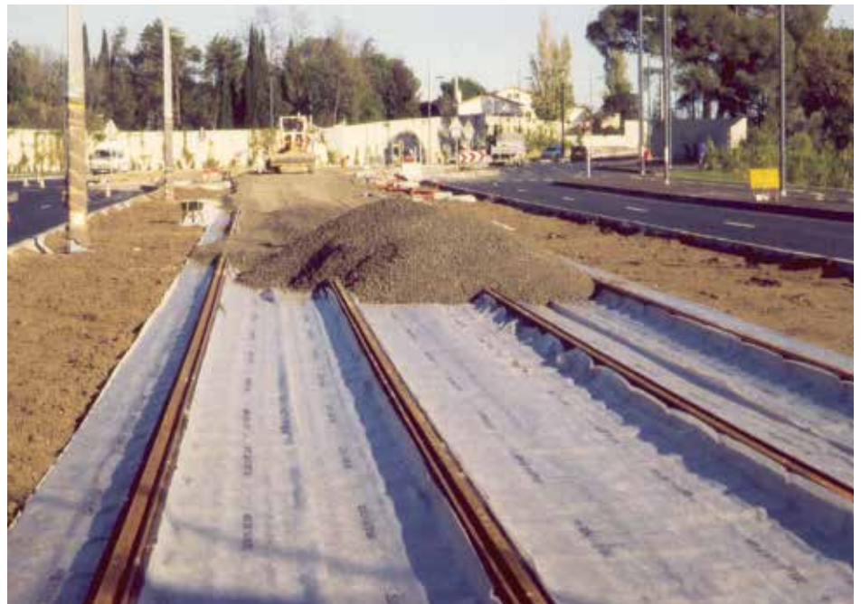
Die Drainagefolie TYPAR eignet sich zum Einsatz im Verkehrswegebau. (Quelle: Du Pont de Nemours)
