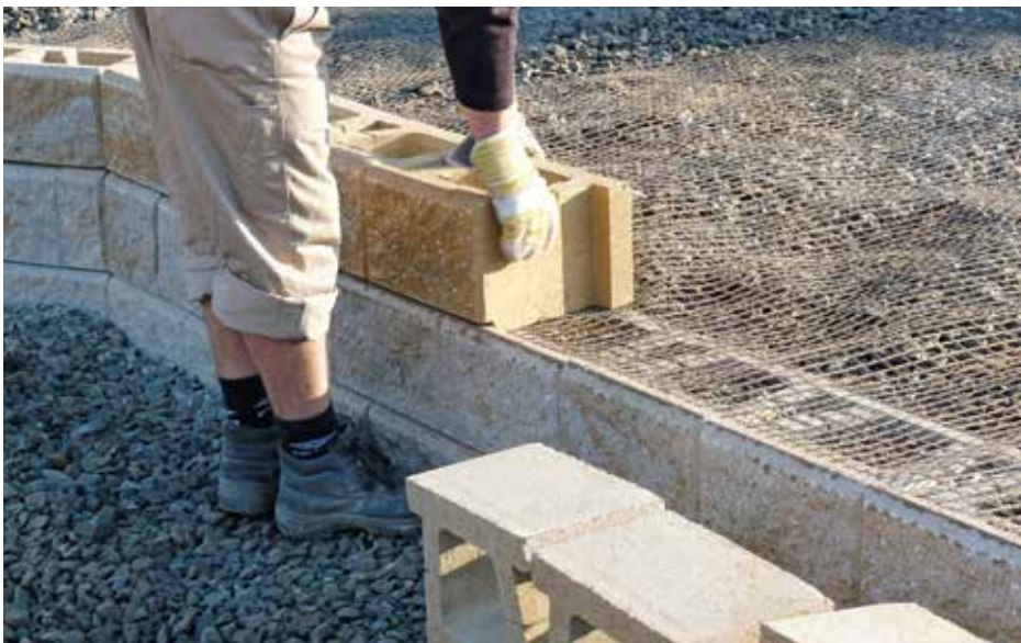
Fortrac® Geogitter - Einbau der Geokunststoffbewehrung (Quelle: HUESKER Synthetic GmbH)
