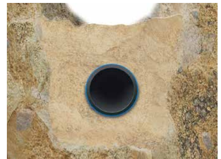
offene Verlegung im Sandbett
