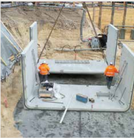
Einbau eines Mall-Löschwasserbehälters im SOS-Kinderdorf in Berlin. (Bild: Mall GmbH)
