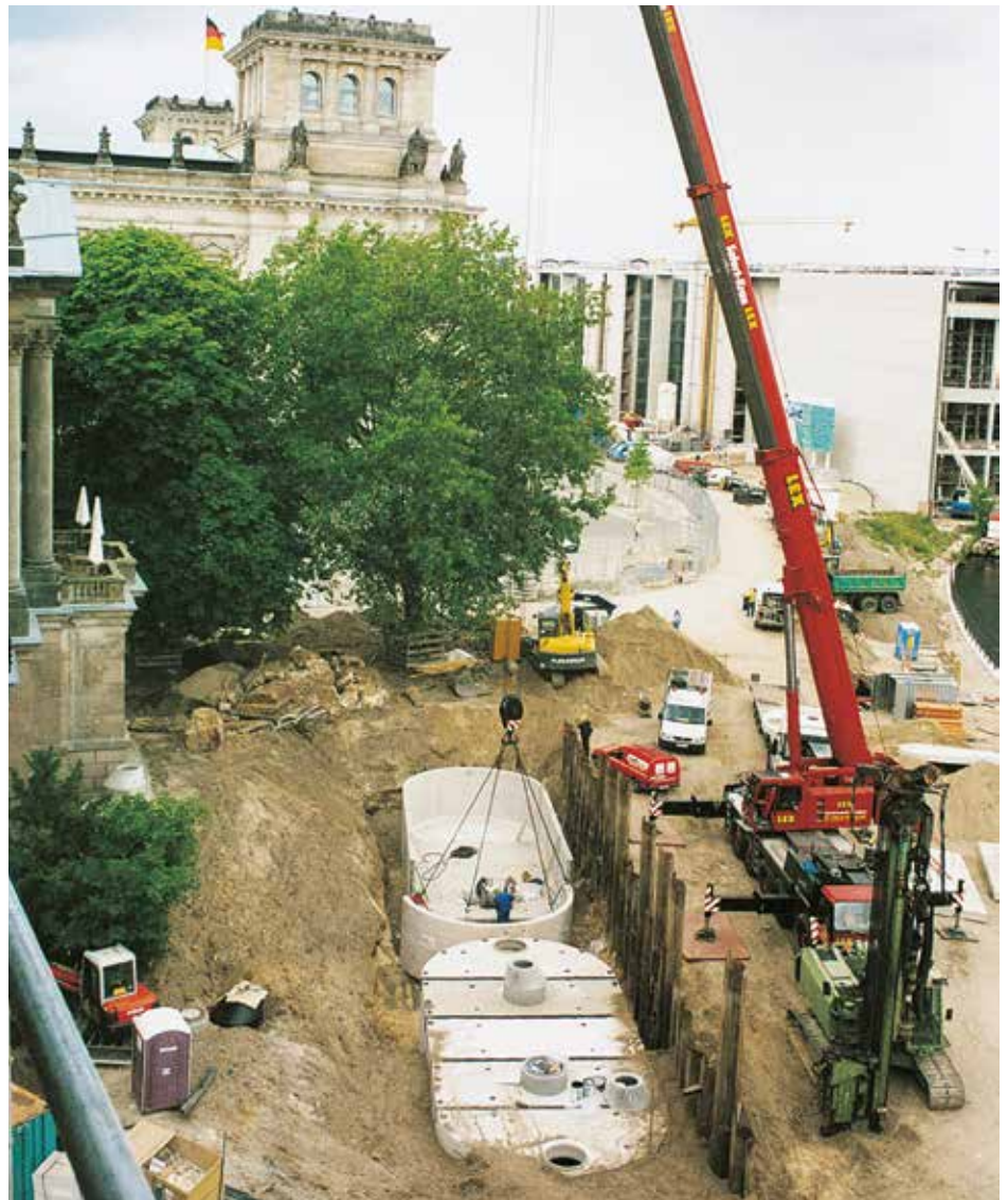
Einbau von zwei Mall-Großbehältern vor dem Jakob-Kaiser-Haus in Berlin, in unmittelbarer Nähe zum Reichstag: Der vordere Behälter ist ein Regenspeicher mit integriertem Filtersystem; das Wasser wird zur Bewässerung der Gründächer verwendet. Dahinter liegt ein Regenrückhaltebecken zur gedrosselten Ableitung in die Spree. (Bild: Mall GmbH)
