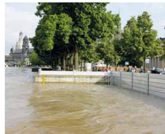
Die mobilen Schutzwände von ThyssenKrupp Bautechnik halten Wasser und Schlamm erfolgreich ab. (Quelle: Andreas Tampe, Landeshauptstadt Dresden)
