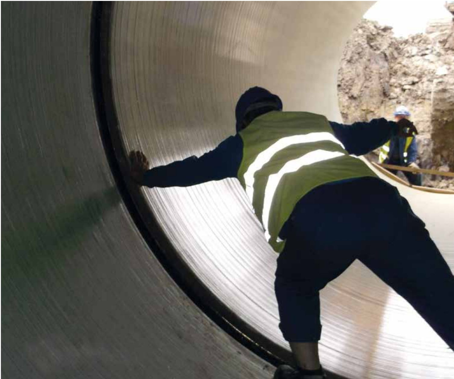
Ausrichten des GfK-Rohres im Graben. Quelle: HTI International Romania
