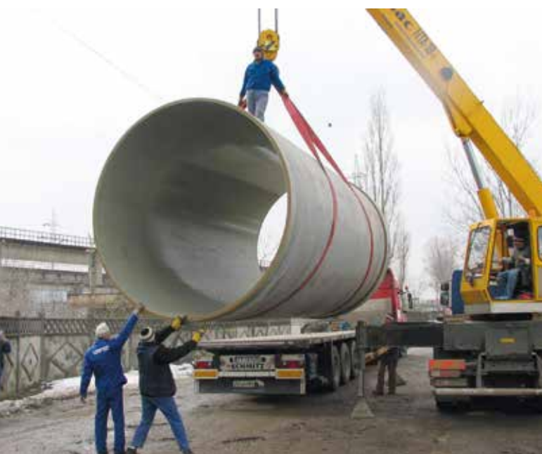
Entladung der Rohre auf der Baustelle in Iași.
