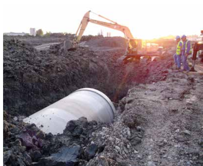
Rückverfüllung des Grabens. Quelle: HTI International Romania
