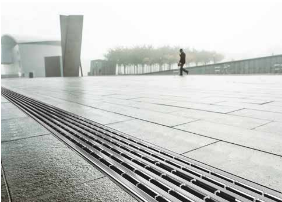
Drainlock Roste des ACO DRAIN® Multiline Systems dienen auch der ästhetischen Gestaltung öffentlicher Plätze. (Quelle: ???)
