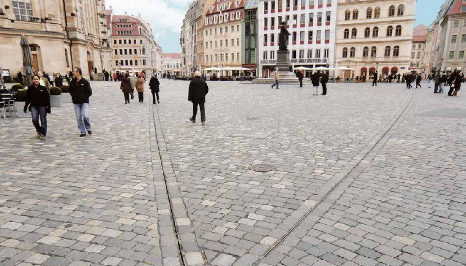
Der Neumarkt in Dresden setzt auf die Entwässerung mittels Schlitzrinnen (Quelle: Hauraton, Rastatt)
