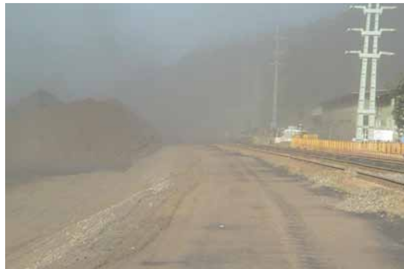
Staubbedingungen ohne Rain Bird System
