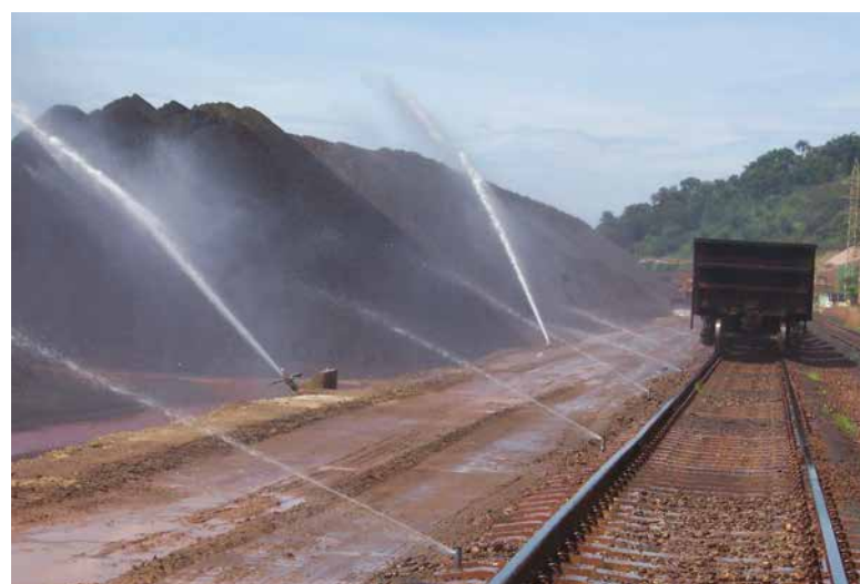
Nach der Installation eines Rain Bird Systems
