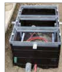
senkrechte Rohr- anbindung
